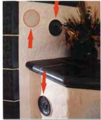
*Das monumentale (Warmluft-)Ofenbauwerk steckt voller Rauchgaszüge, deren Reinigungsnotwendigkeit durch eine Reihe von Putzdeckeln dokumentiert wird.*
