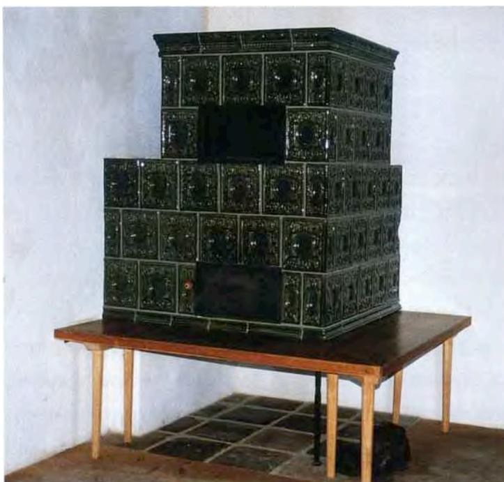
*Die „Heizkraft“ eines Kachelofens wird nur sehr vordergründig durch seine Größe bestimmt. Tatsächlich bestimmt die Strahlungstemperatur die Stärke der Wärmeabgabe in viel größerem Umfang. Bei voller Heizleistung ist es auf der beliebten Ofenbank in der Regel viel zu warm, ebenso am Tisch und auf der Eckbank unmittelbar neben dem Ofen.*
